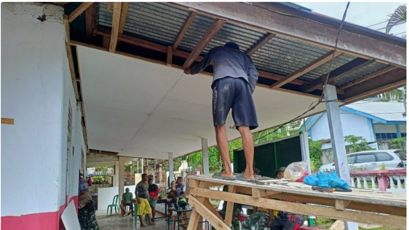
Satgas TMMD Renovasi Kantor Kelurahan Tandurusa
